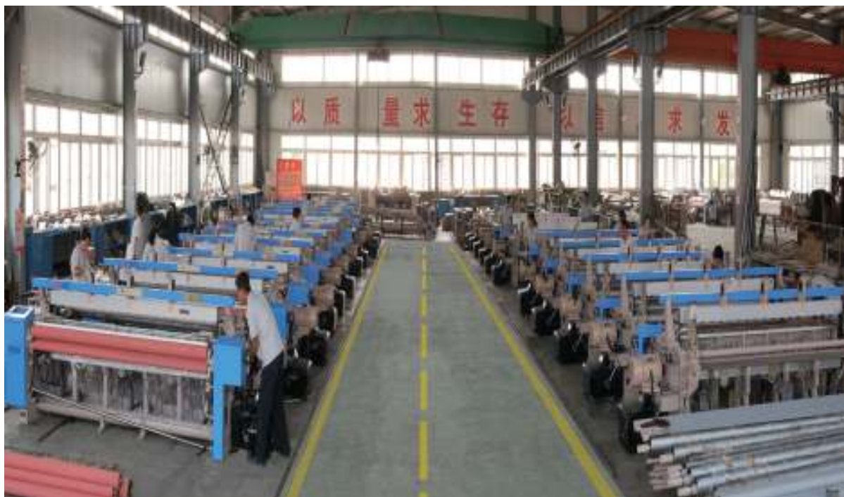
喷气织机安装车间
