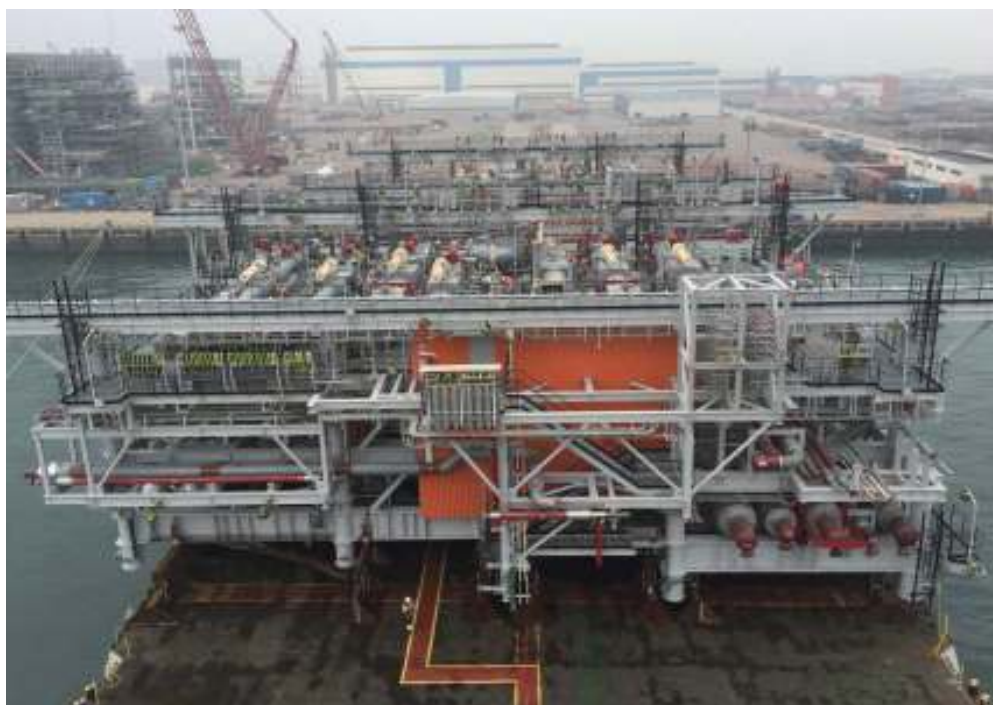
青岛星河国际海洋工程有限公司 海上天然气工程项目施工现场
